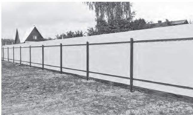
Конструкция такого забора бывает разной. Разница в том, какие используют столбы. Их можно сделать из металлических столбов, а можно сделать и кирпичные столбы. К металлическим столбам привариваются поперечные лаги. А уже на лаги начинают крепить листы. Вместо саморезов рекомендуем использовать заклепки. Если ваш забор достаточно высокий, более 2 метров, то опытные строители рекомендуют использовать три лага вместо двух. Такая конструкция придаст конструкции жесткость, надежность и безопасность.
