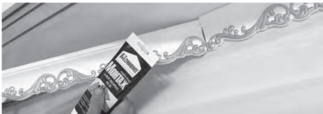
Для корректировки плит, плинтусов и других декоративных элементов имеется 15 минут. Допускается заполнение щелей толщиной до 10 мм. Рабочая толщина полосы, выдавленной из тубы/тюбика составляет 5 мм. Высыхание клея зависит от слоя, может превышать 48 часов. Расход может достигать 9 погонных метров (при 6 мм) либо 0,2-0,4 кг/м<sup>2</sup> (при сплошном нанесении). После высыхания клей можно окрашивать водорастворимыми красками (предпочтительно).
