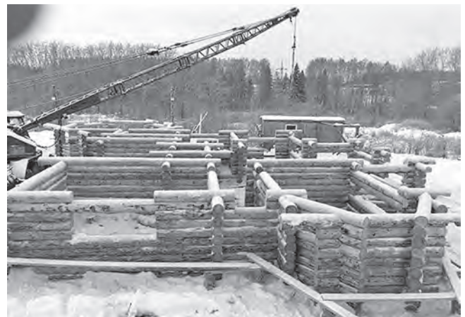
Рубка сруба с трапециевидным эркером
