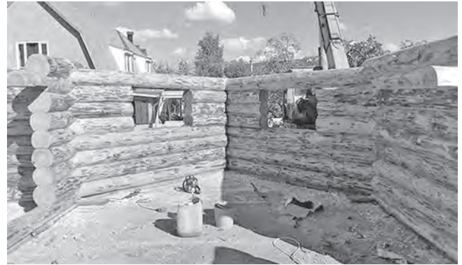
Сборка сруба с треугольным эркером
